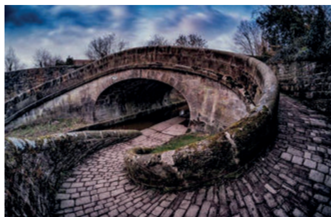
Ingénieurs « Pont Serpent » construit en 1831 sur le canal Macclesfield en Angleterre permettant aux chevaux de halage de changer de côté sans avoir besoin de se détacher du bateau.
